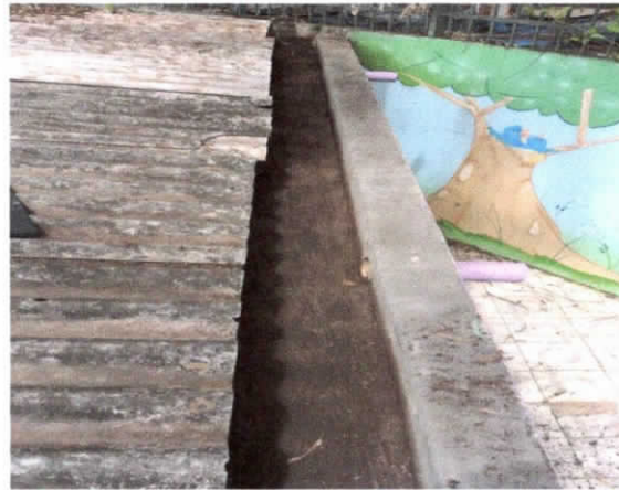
Manutenção telhado / março
