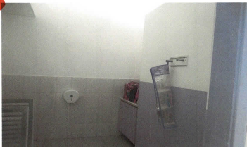
Pintura banheiro sala 33 / março
