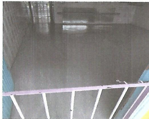
Colocação de Paviflex nas salas Mini II A Mini II B e Mini II C
