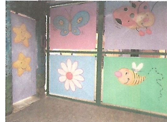
Colocação e pintura do portão de entrada
