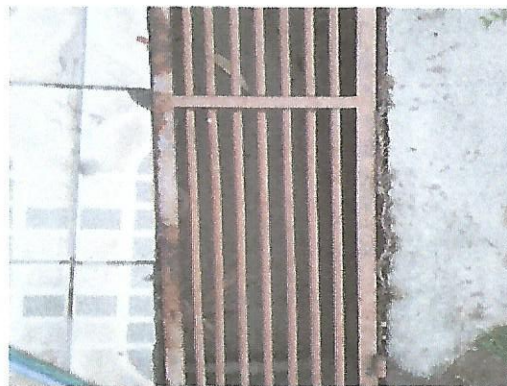
Limpeza das grelhas e nivelção com Cimento para caimento da água
