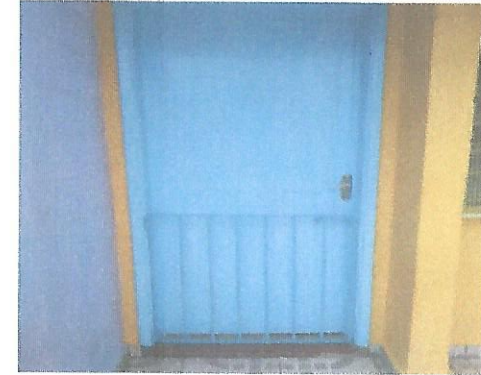
Instalação de porta de ferro na sala Mini grupo I E/F
