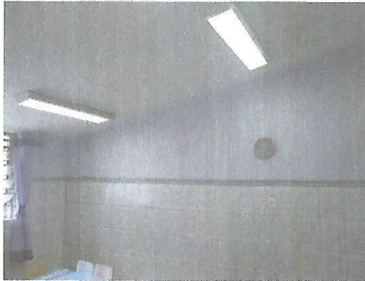
Pintura do refeitório dos Berçários
