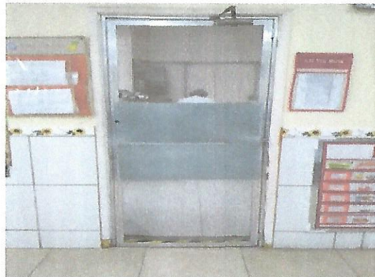
Colocação de tela na porta da cozinha
