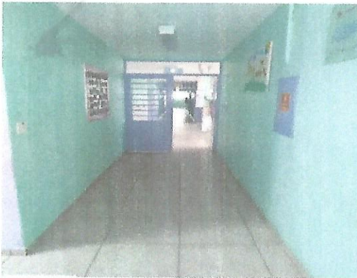
Pintura do corredor
