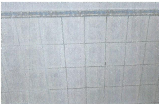
Remoção e colocação de revestimento nas salas MII D, refeitório pequeno e MIIC
