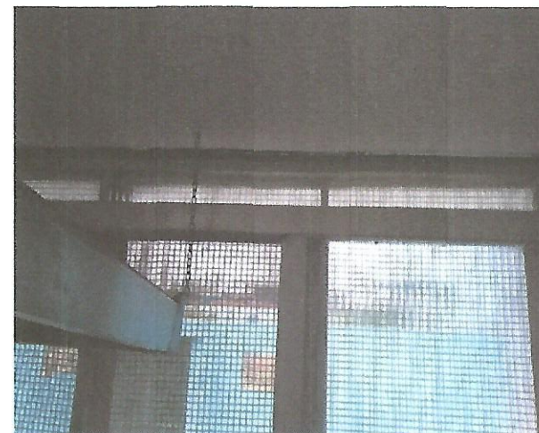
Troca de vidro quebrado na cozinha
