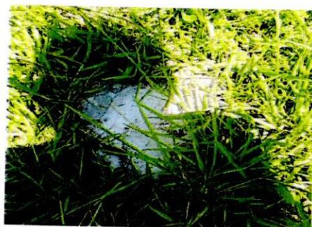
FECHAMENTO DO BURACO
