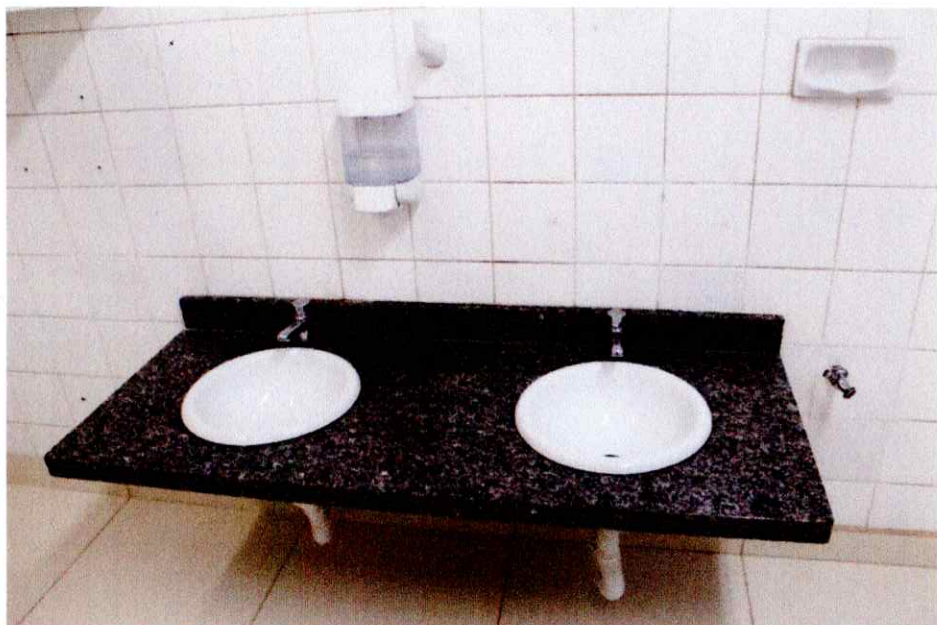
Adequação do Lavatório
