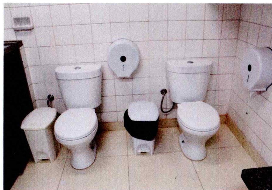
Implantação dos Vasos Sanitários nas Salas dos Berçários BII A e B
